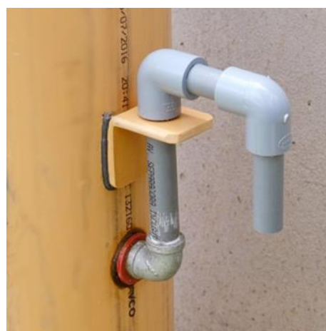
FIGURA 3. SOPORTE DEL TUBO DE SALIDA.
